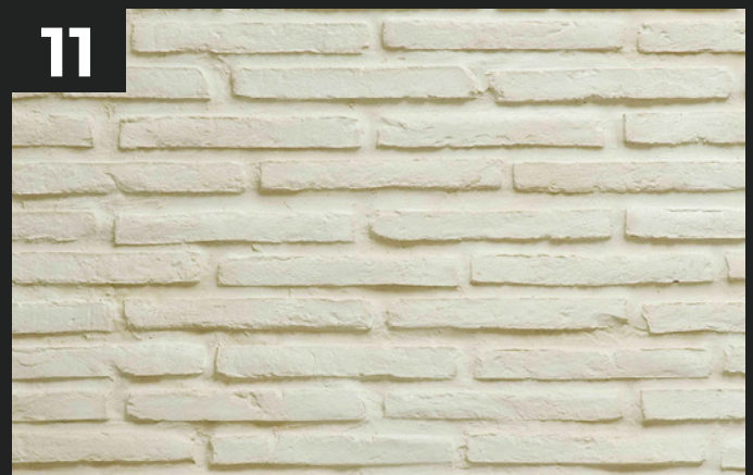
11. Nach dem Trocknen ist die Installation abgeschlossen Installation finished after drying
