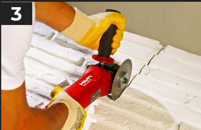
3. Paneele mit Winkelschleifer zuschneiden Cutting the panel by angle-grander
