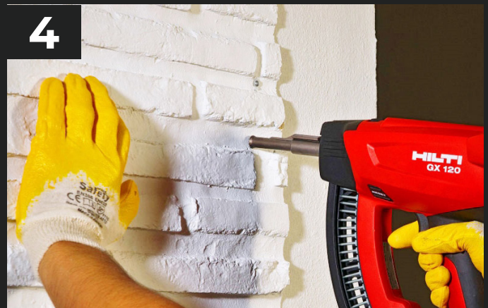
4. Anbringen mit Nägeln ... Assembling by nails ...
