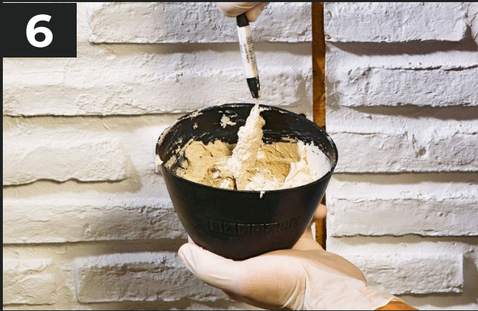
6. Spachtelmasse vorbereiten Preparing the assembly putty
